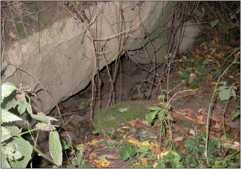
Abb. 12: Bunker 369 (B1) (Foto: Martin Lillig)
