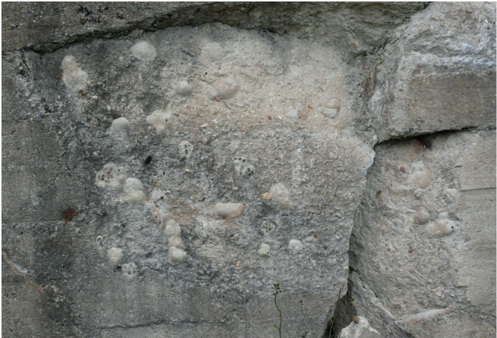
Abb. 15 a, b: Vergleich am Niststandort: Am 20.5.2012 waren aus vielen Nestern schon Mörtelbienen geschlüpft (Löcher!). Zwei Wochen später, am 5.6., waren viele alte Nester schon repariert und „neu verputzt“.
